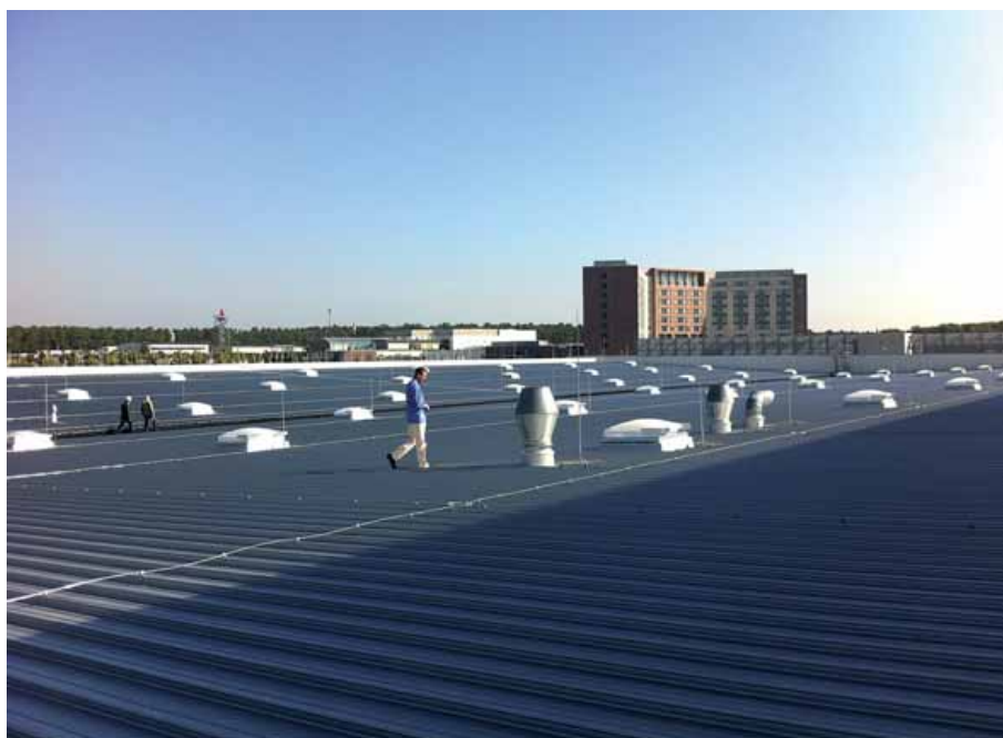
Dachhaut Freight Terminal AB Ramstein (im Hintergrund: Kaiserslautern Military Community Center / KMCC) 03.01.2013 / AB 21
