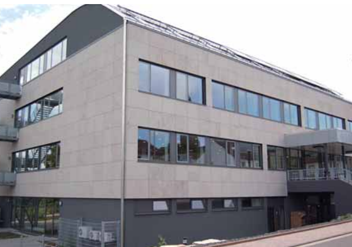
Hauptgebäude mit zusätzlichem Geschoss und neuer Fassade.
